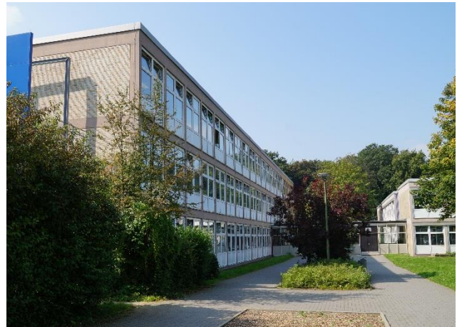
Schulgebäude der Sek I
