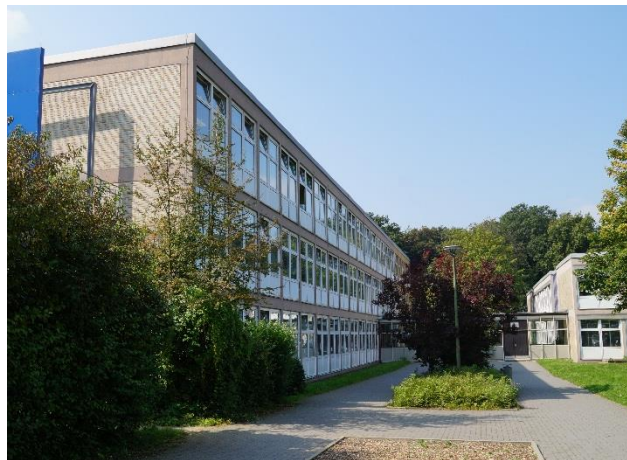
Schulgebäude der Sek I
